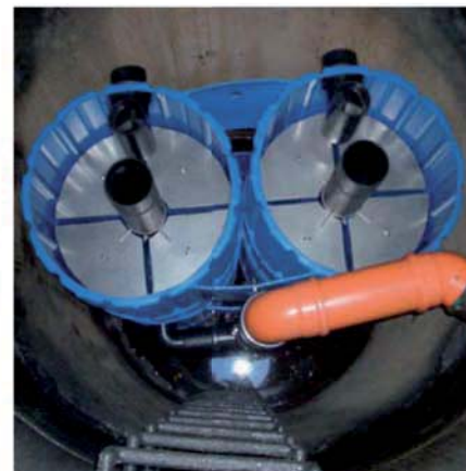
Aufbau des Filtersystems im Untergrund
