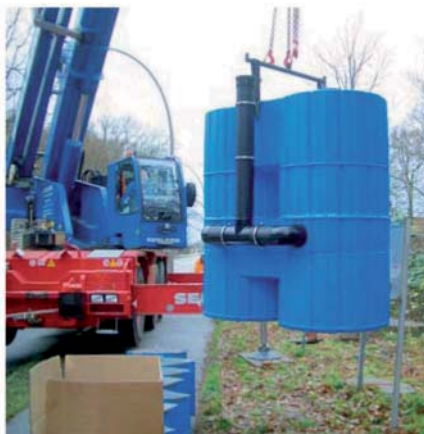
Versatz des Doppelschachtes mit integriertem Filtersystem
