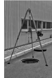
1. Rettungs-Dreibein über dem geöffneten Schacht
