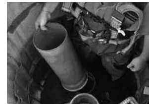
1. Überlaufrohr aus der Muffe ziehen und aus dem Schacht herausheben
