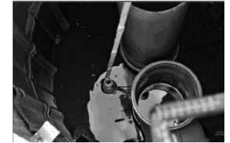
3. Bei Metalldachanlagen Wasserprobe oberhalb der Filterelemente entnehmen
