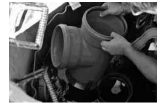
3. T-Tück komplett herausnehmen und aus dem Schacht herausheben
