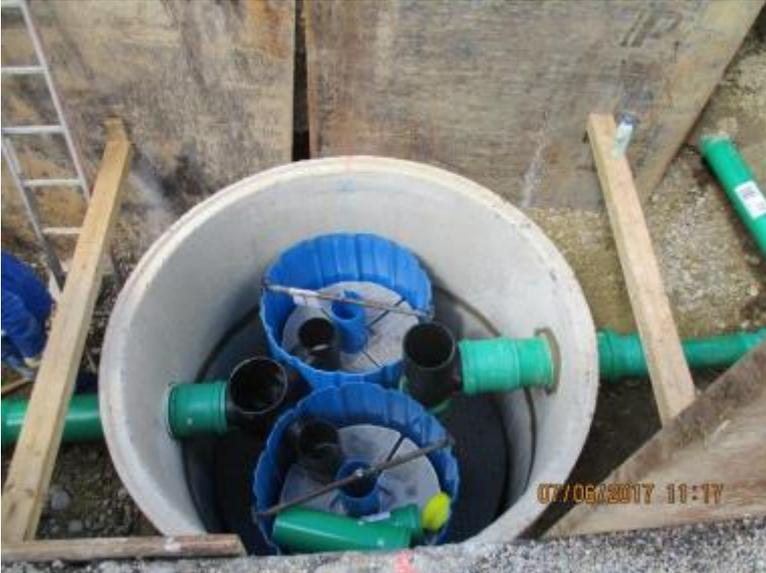
Eingesetzte Behandlungsanlage Hydrosystem heavy traffic in der Zwillingversion. Zulauf rechts im Bild, Ablauf entsprechend links wobei die Winkelverhältnisse variabel sind.
