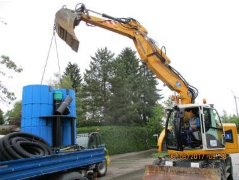
Auf Grund der kompakten Bauweise und den leichten Materialien ist das Versetzen des Systems mit einem Baustellengerät möglich, welches auf jeder Tiefbaustelle vorhanden ist.
