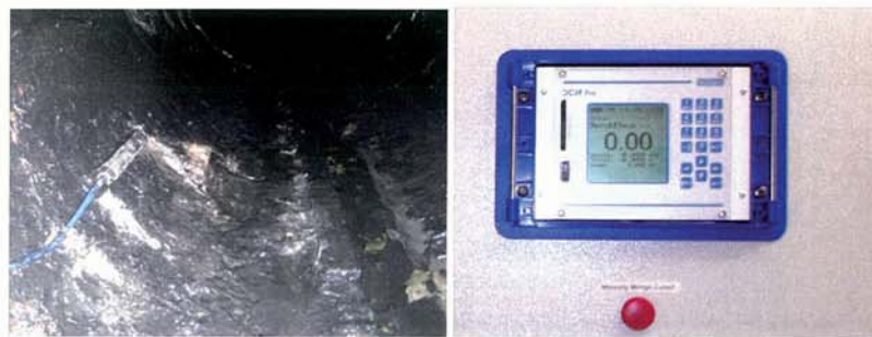
Bild 8 Einbaulage von OCM und Messwertumformer der Zulaufmessung
