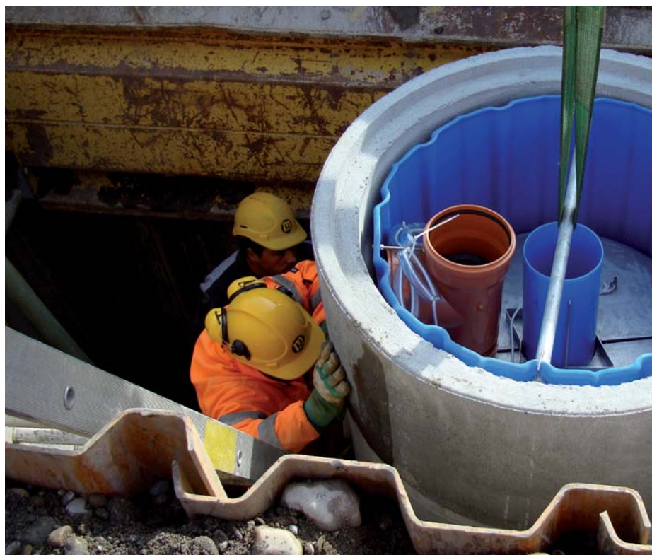
Abb. 2: Der Einsatz von Böschungsverstärkungen und Abfangmaßnahmen ist während des Einbaus unbedingt erforderlich.
