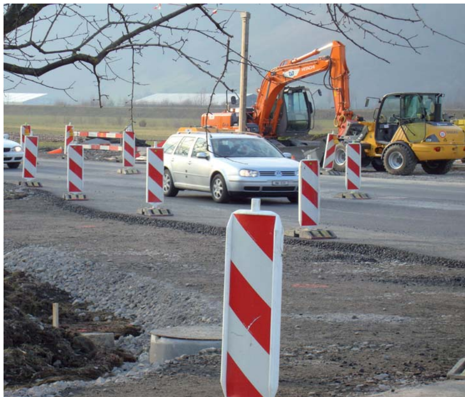
Abb. 1: Im Zuge der Umbauarbeiten wurde das Hydrosystem ohne signifikanten Zusatzaufwand und weitere Absperrmaßnahmen in den Verkehrsraum eingebracht.
