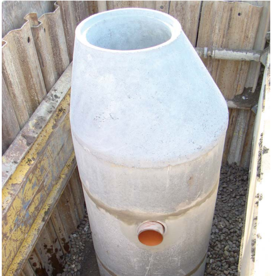
Abb. 3 (oben): Das fertig eingebaute Hydrosystem muss nun nur noch an das Abwassersystem angeschlossen werden. Hier wurden die einzelnen Segmente noch wasserdicht verfugt. Das ist bei dem weiterentwickelten Hydrosystem durch die monolithische Bauweise nicht mehr notwendig.
