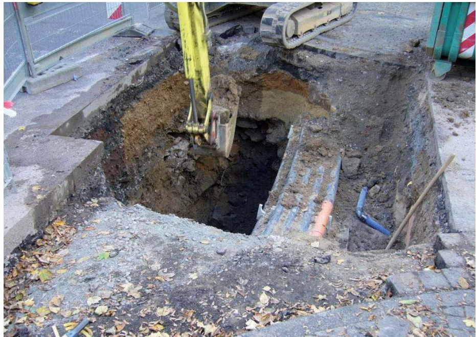
Abb. 2: Ausheben der Baugrube
